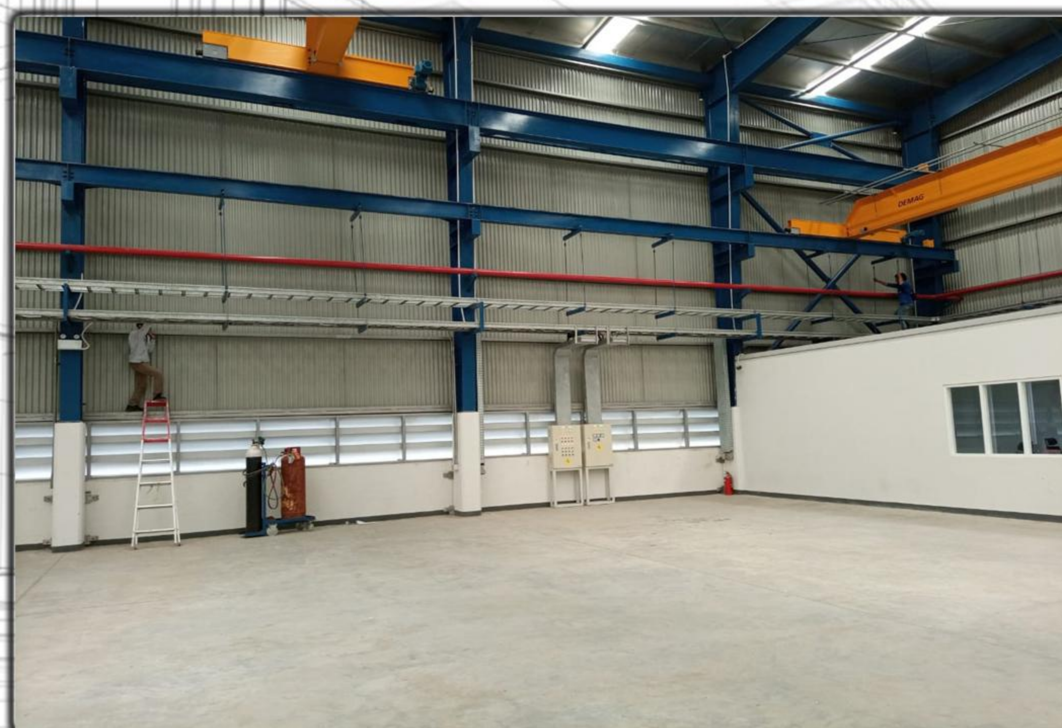
Pengecekan kabel LAN cctv Magdatama
